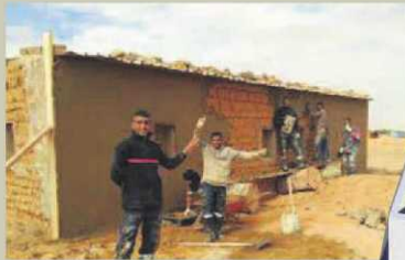
Trabajos en el parque de bomberos de Rabunni.
