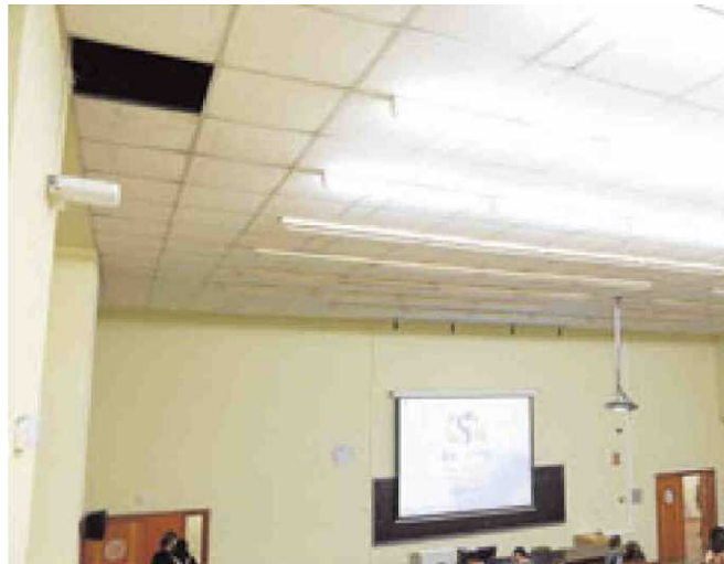
En un aula de Medicina han levantado otra placa del falso techo para solucionar un problema de humedades. | ALMEIDA
