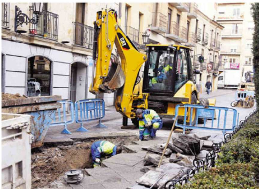
Obras de reparación de una tubería, una de las inversiones a las que se destinará el superávit municipal. | ARCHIVO
