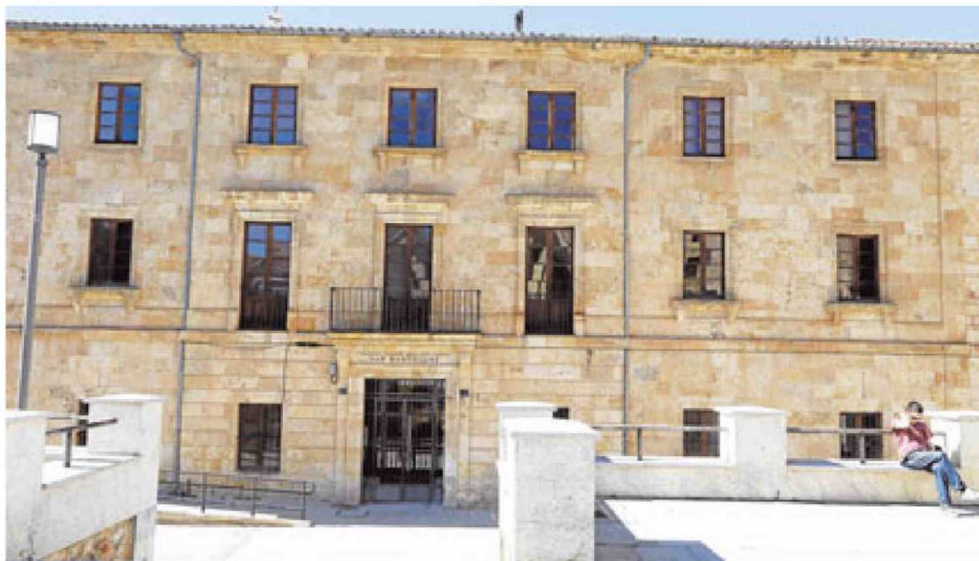
Fachada principal del edificio del antiguo colegio mayor de San Bartolomé. | ALMEIDA
