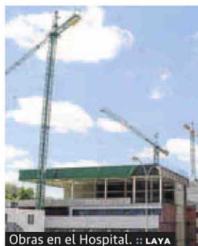
Obras en el Hospital. :: LAYA
