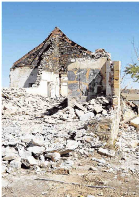
Una construcción del Polvorín de Tejares, a medio demoler.
