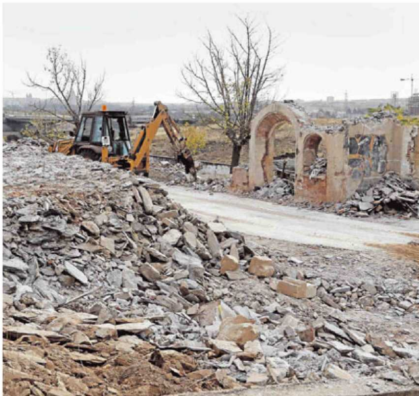
Una máquina derriba las últimas estructuras que quedan en pie de un antiguo edificio militar. | FOTOS: ALMEIDA
