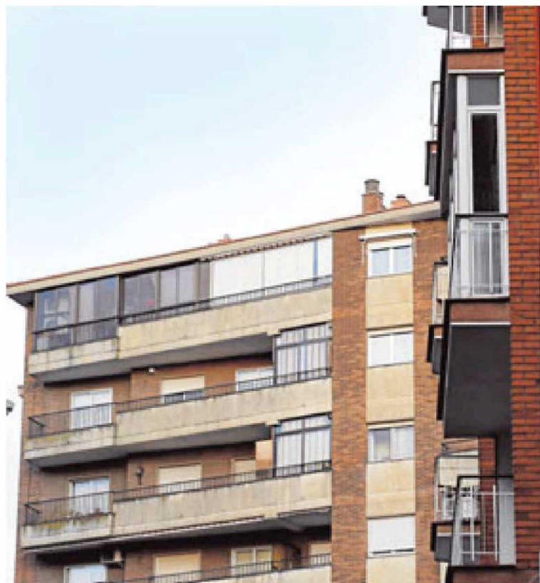
Cerramientos en varios balcones de edificios de la ciudad. | ALMEIDA
