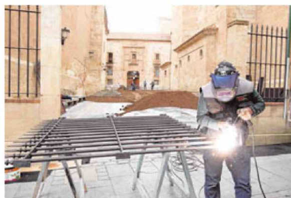
Un operario trabaja en la verja construida frente al Palacio de Maldonado.
