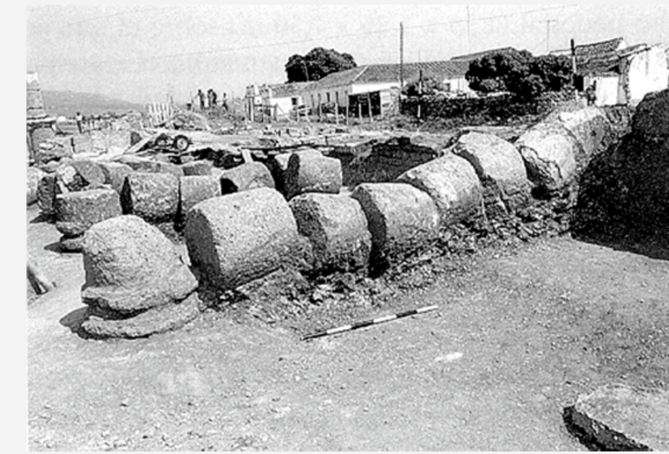
Caída orientada de Columnas Basílica (Terremoto y Tsunami)
