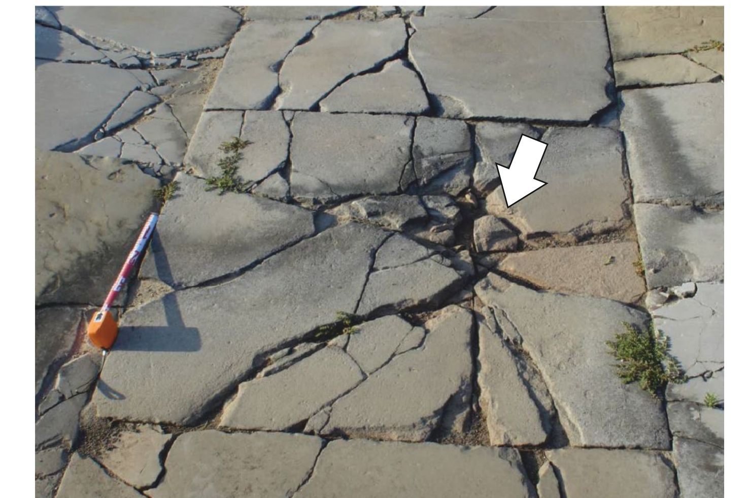
Marcas de impacto en enlosados por caída de capiteles y otros Basílica
