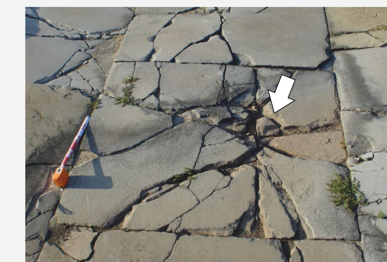
Marcas de impacto en enlosados Por caída de capiteles y otros
