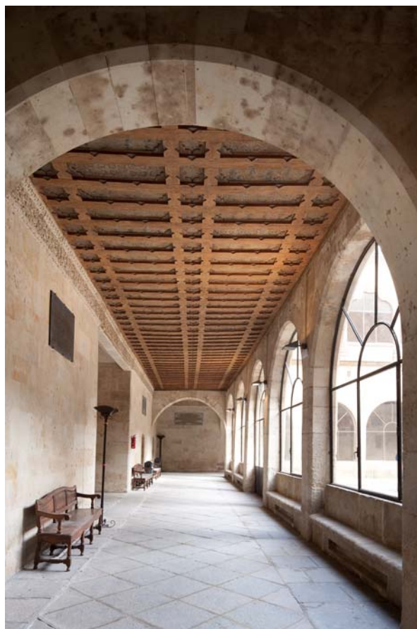
ESTADO FINAL RESTAURADO
