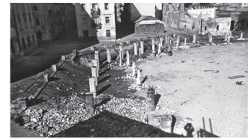
Lo que quedó del edificio.
