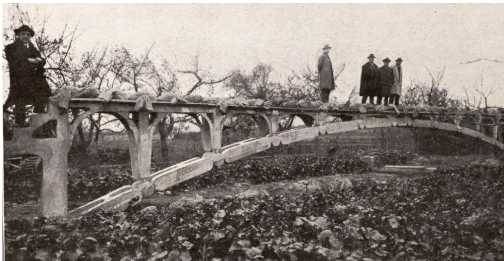
Figura 3 | Aplicación de prueba de carga en arco funicular.
