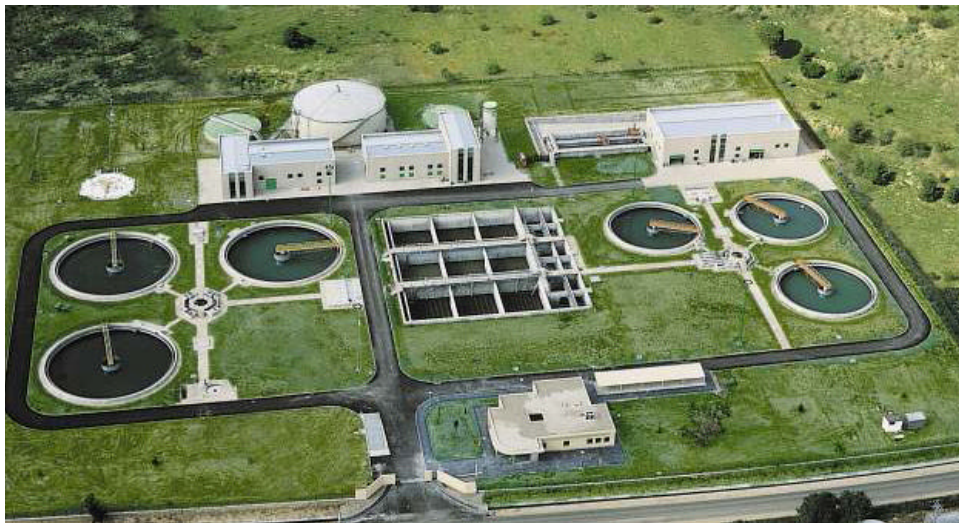
Estación Depuradora de Aguas Residuales de Zamora
