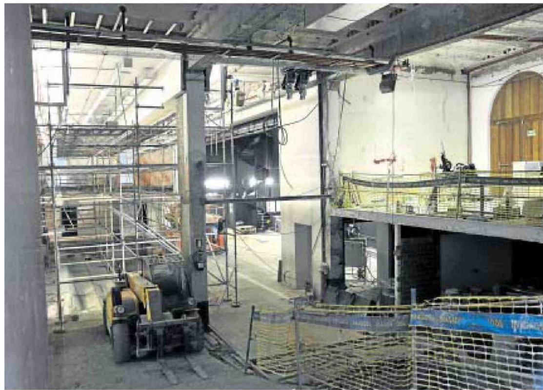
Imagen interior de las obras de rehabilitación del teatro Juan del Enzina en el edificio de Anayita./BARROSO
