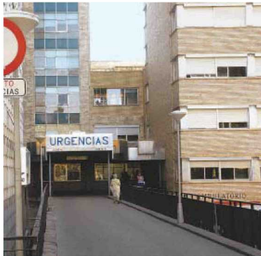
El biobanco está ubicado en la antigua zona de ambulatorio del Virgen de la Vega.
