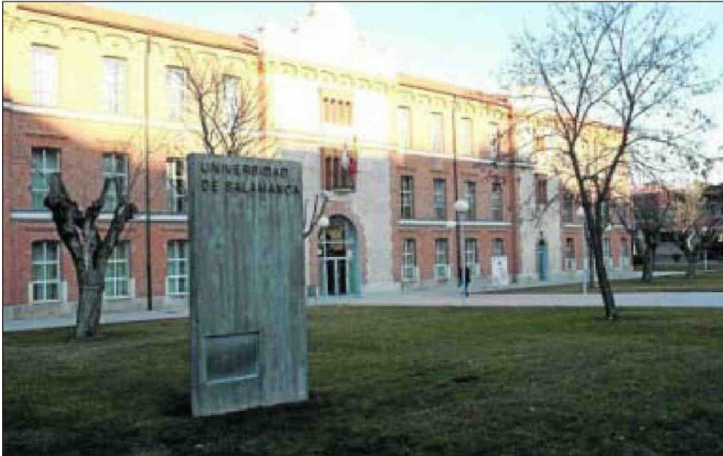
Instalaciones de la Usal en Zamora.
