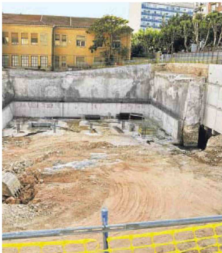
Estado de las obras del edificio de la calle Espejo. /BARROSO
