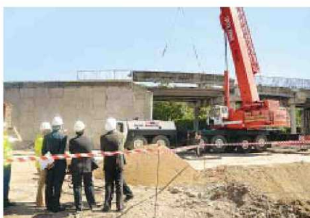
Una grúa de grandes dimensiones procedió al desmontaje./M.BARROSO
