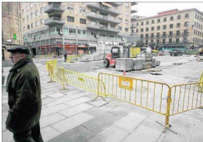
PROYECTO. La plaza de San Julián lucirá su nuevo aspecto tras varios meses de obras en los que permaneció cortada y cerrada. ALMEIDA
