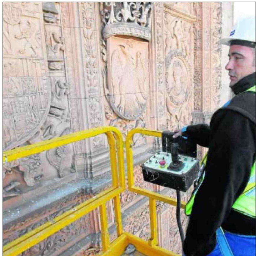
Un técnico revisa la fachada de la Universidad subido en una plataforma elevadora, ayer.
