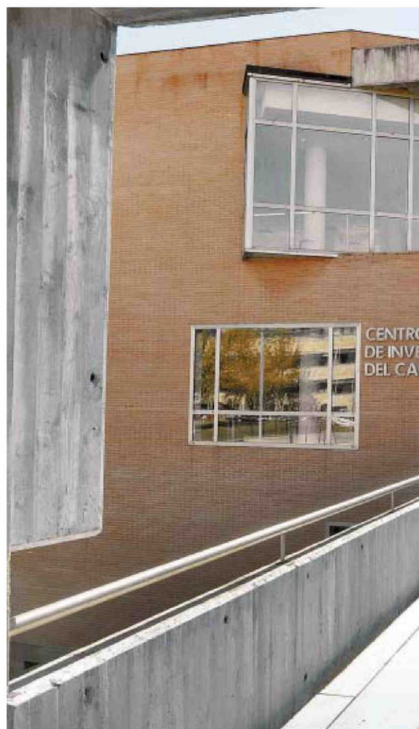
Edificio del Centro de Investigación del Cáncer de Salamanca.
