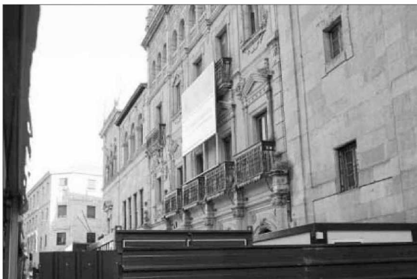
Las obras del Centro Documental de la Memoria Histórica siguen adelante.
