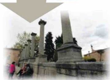
COLUMNAS DEL ATRIO DE LA CATEDRAL De las primeras en usar el material en 1535
