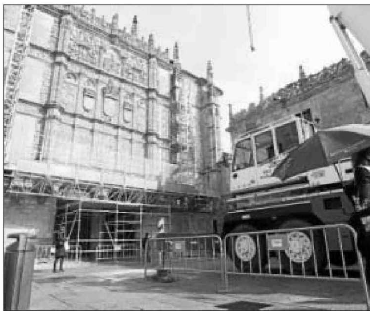
Andamio en la fachada de la Universidad de Salamanca.
