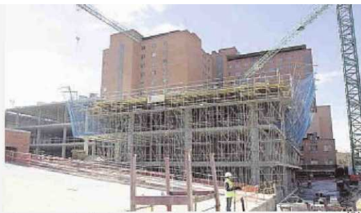
Obras en el Clínico de Valladolid
