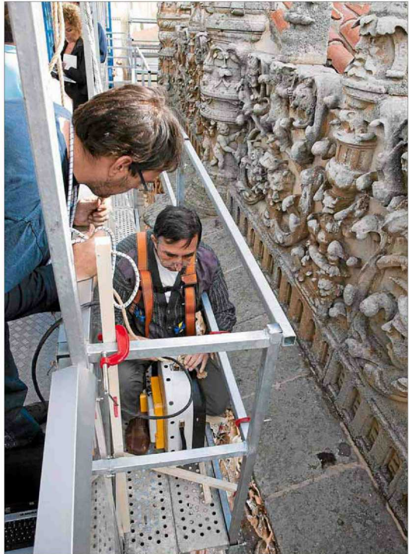
El técnico utiliza el georradar para analizar la fachada de la Universidad de Salamanca. / ICAI
