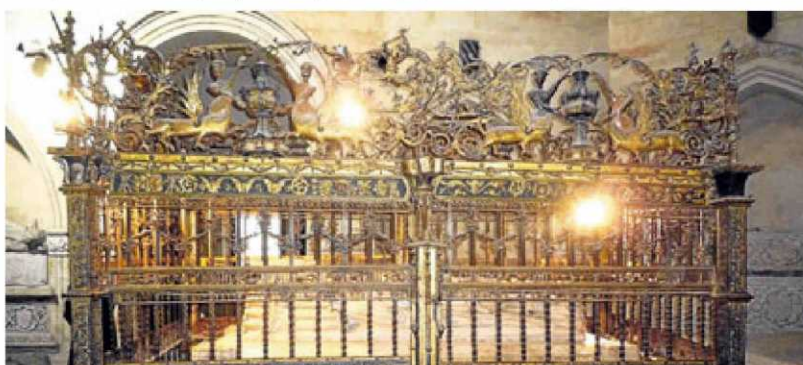
La reja de la Capilla de Anaya vista desde el lado de la Epístola, donde faltan dos ángeles en los ángulos superiores.
