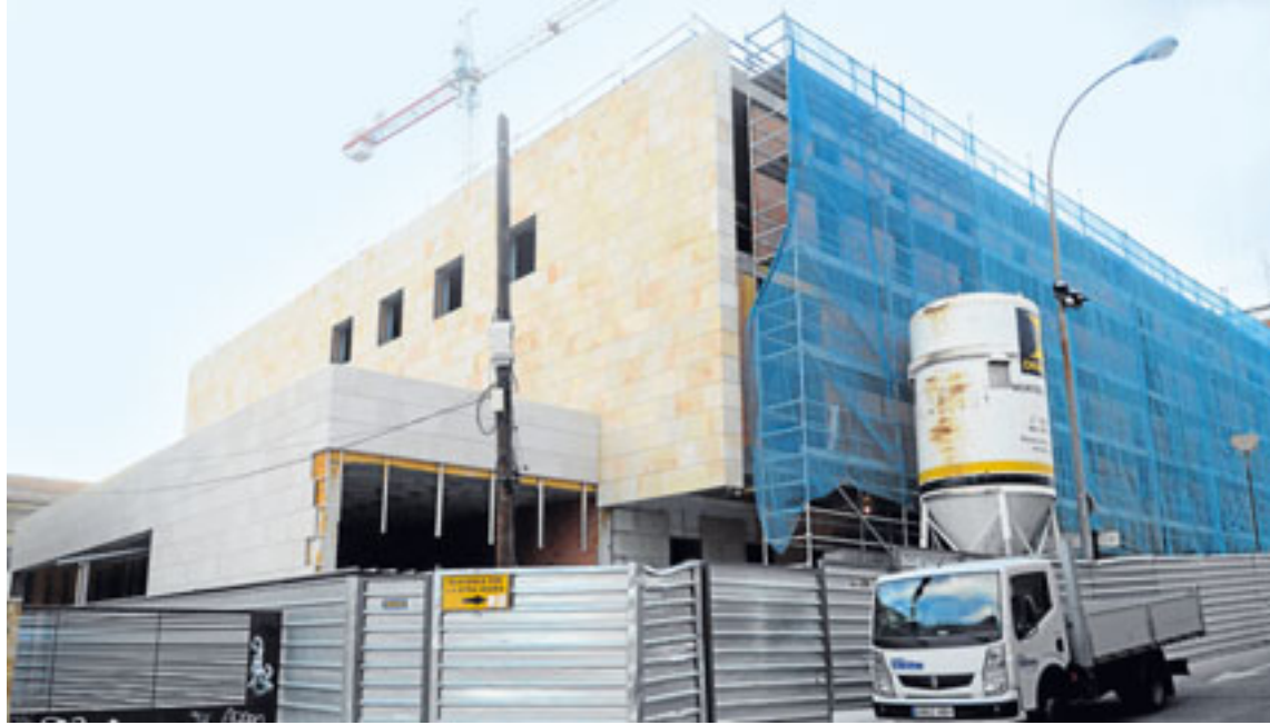
Obras del edificio multiusos de I+D+i, situado entre la calle Espejo y el paseo de San Vicente. /BARROSO
