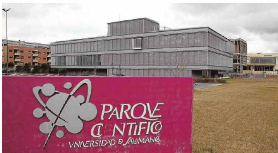
Edificio del Parque Científico de la Usal en Villamayor
