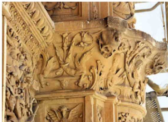
Detalle de la famosa rana que se podía apreciar desde el andamio.
