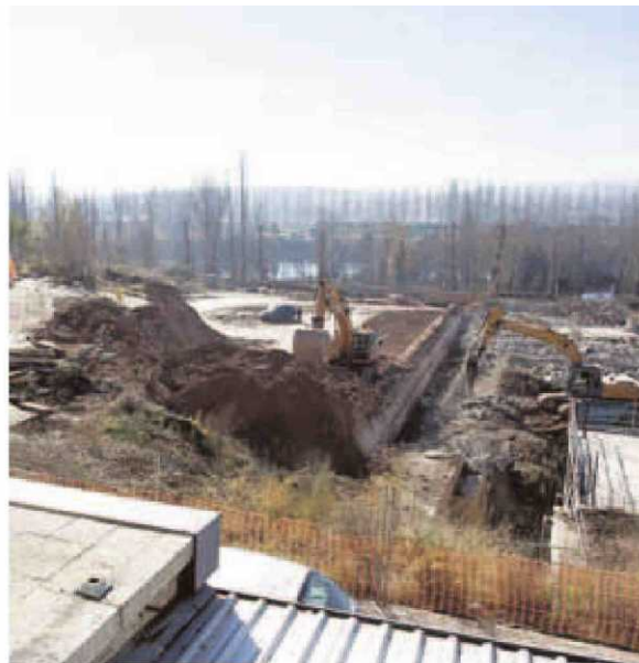
Aspecto actual de las obras en la zona hospitalaria. :: ALMEIDA
