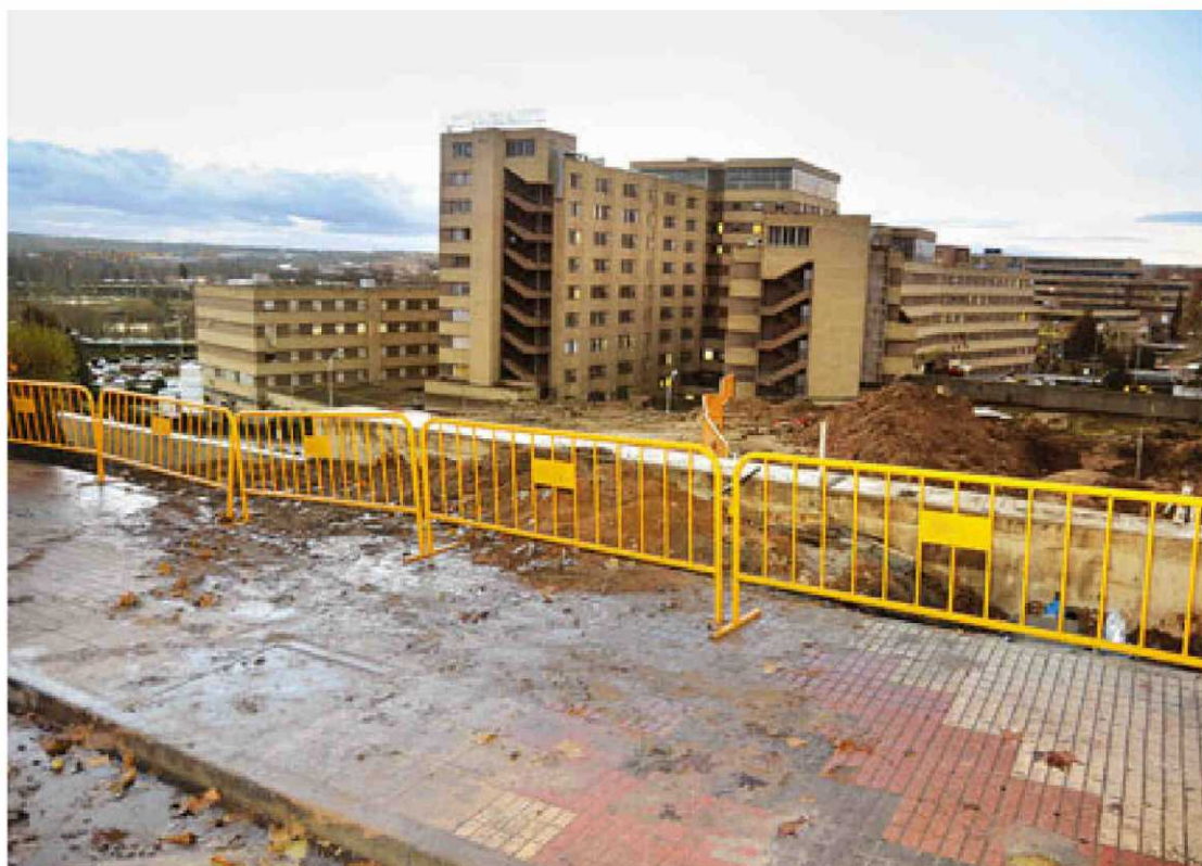
Obras en el paseo de San Vicente, junto a la parcela que ocupará el futuro bloque quirúrgico del Hospital. | BARROSO
