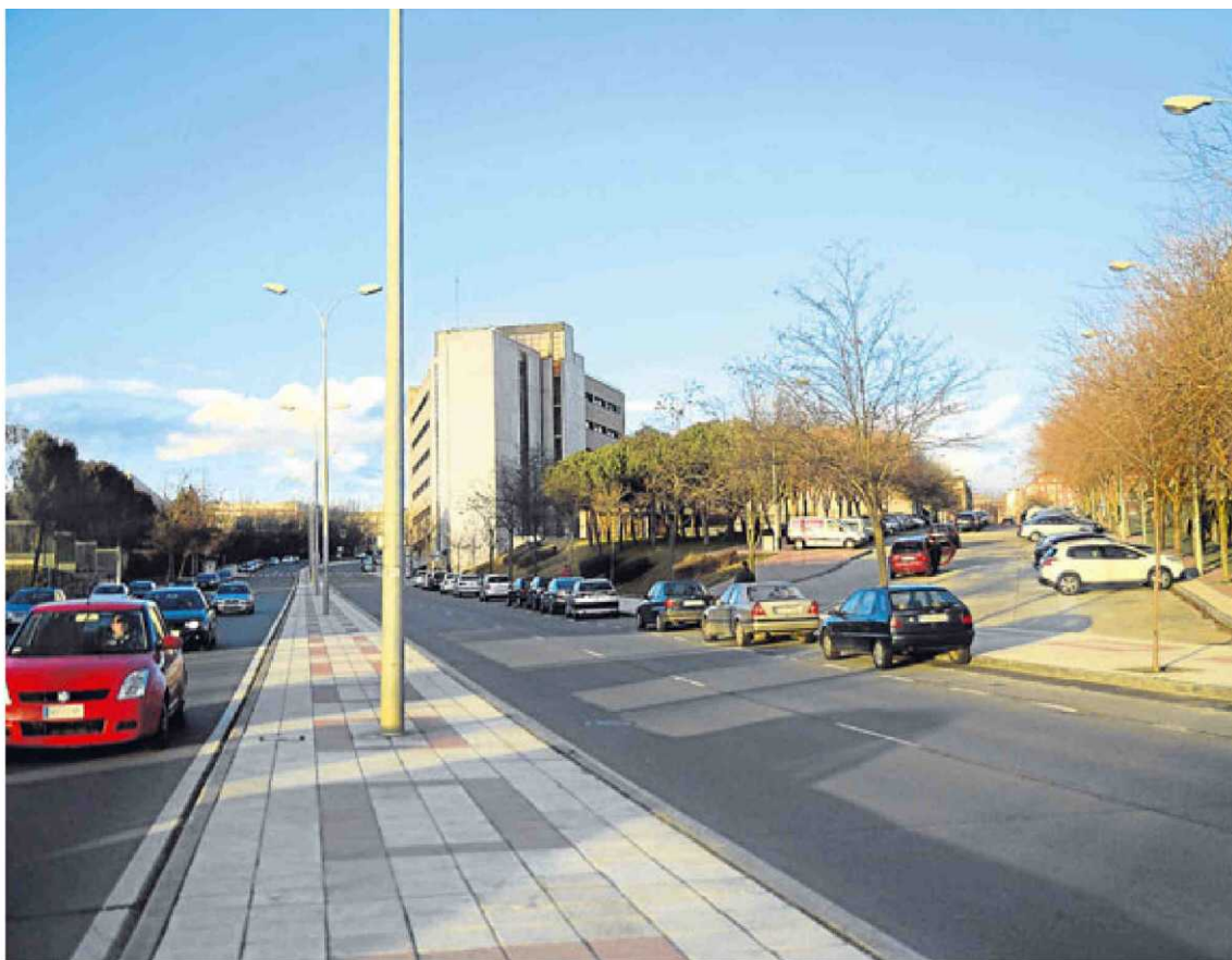
Trasera del edificio FES por la que la Universidad quiere que se cree una nueva entrada o salida al Campus Miguel de Unamuno. | BARROSO
