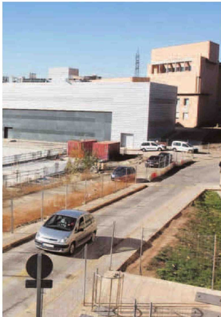
Aspecto de las obras en la trasera del hospital. :: ALMEIDA
