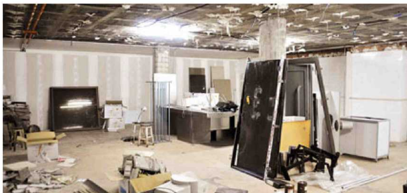
Obra en los sótanos de la Facultad de Medicina. | BARROSO
