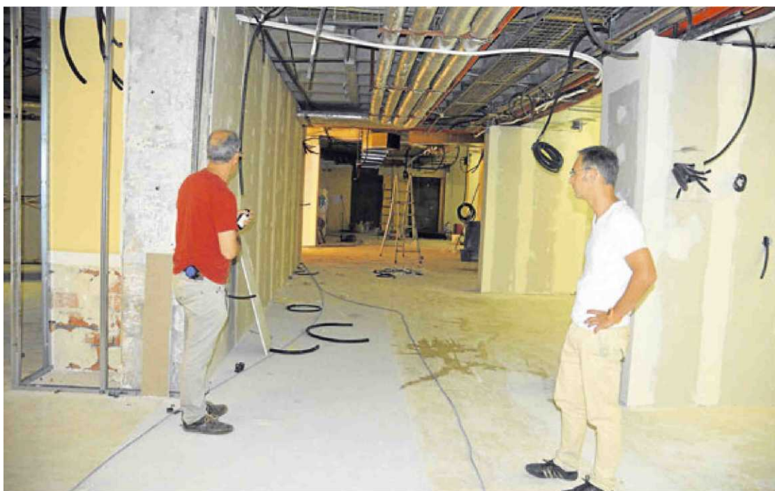
El decano de Derecho, Ricardo Rivero (derecha) visita las obras que se están realizando en los sótanos de la Facultad. | FOTOS: BARROSO
