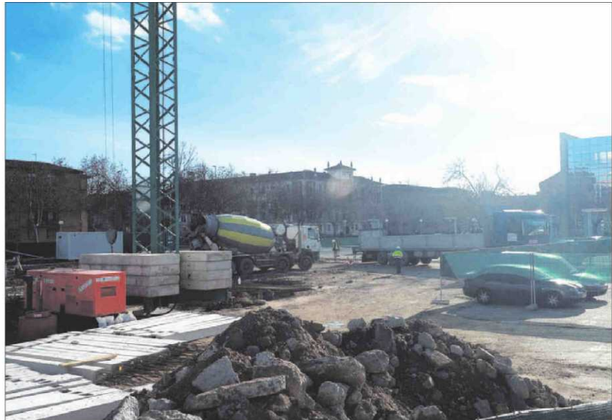
Las máquinas, en la parcela municipal donde se levantará la nueva escuela de Enfermería. | FOTO EMILIO FRAILE
