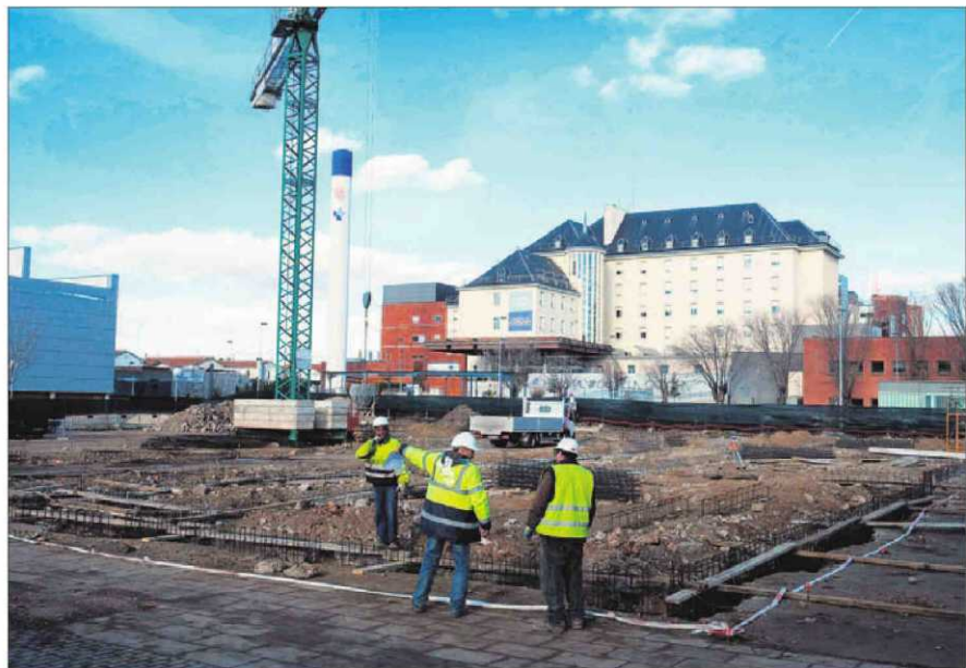
Varios trabajadores, durante el desarrollo de las obras. | FOTO EMILIO FRAILE
