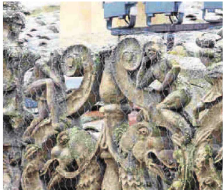
La crestería se encuentra protegida con una malla metálica. ::
