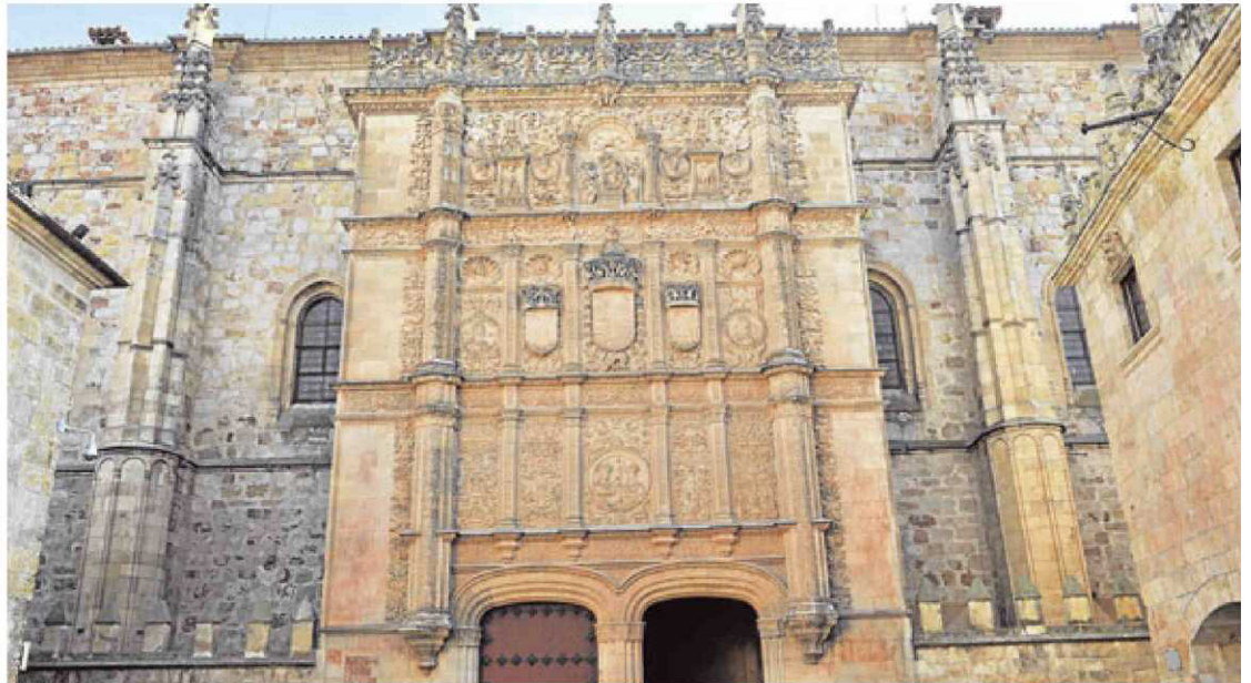
Fachada del edificio de las Escuelas Mayores de la Universidad de Salamanca. | ARCHIVO
