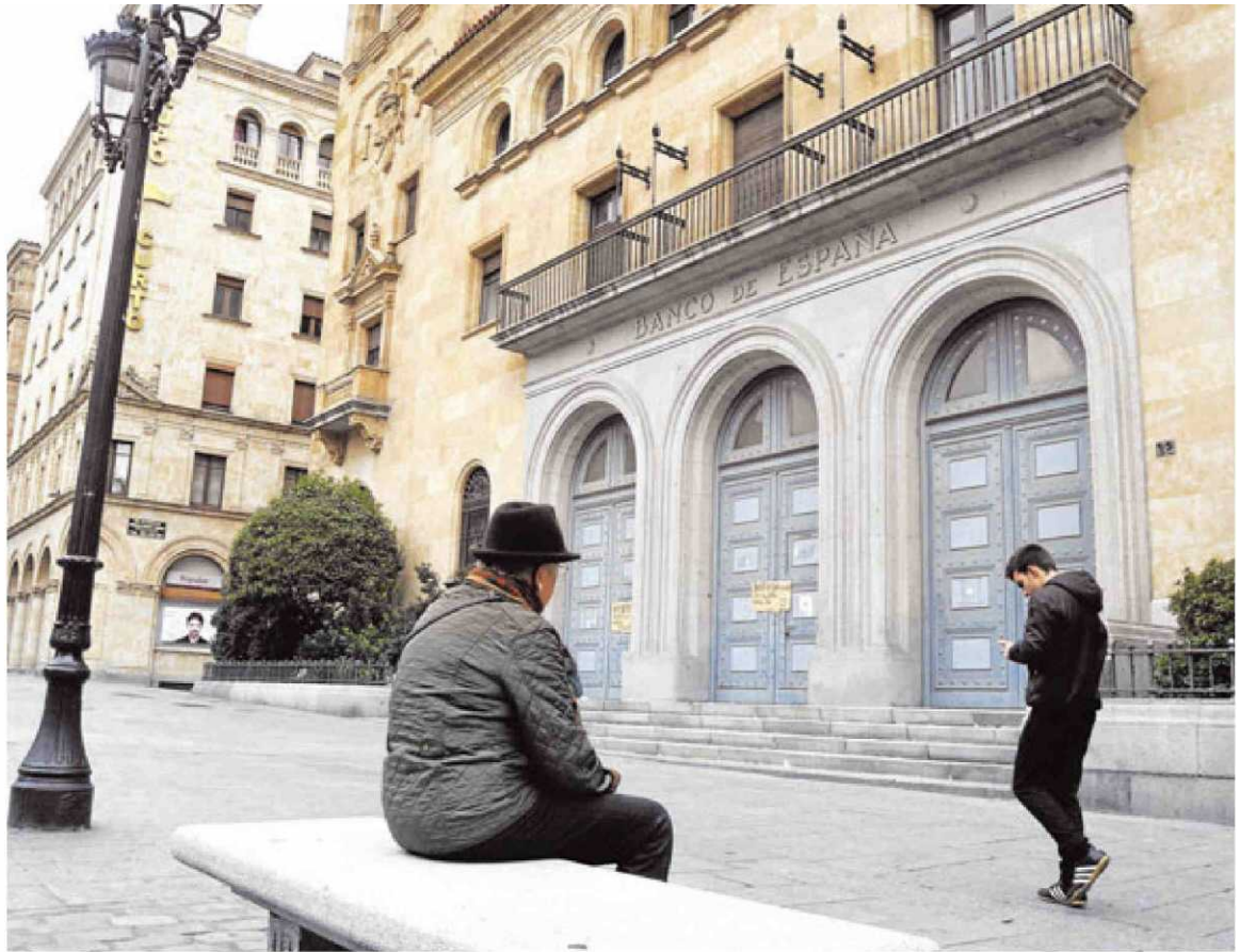
Entrada principal del edificio que acogió la desaparecida sucursal provincial del Banco de España y que actualmente carece de uso. | BARROSO
