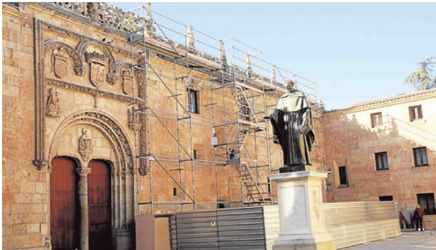
Los andamios que cubren parte de la Crestería de la Universidad y la chapa que ocultará las casetas de obra. | BARROSO
