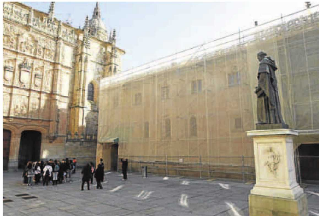
Espacio en el que se instalará el reloj que comenzará a funcionar el próximo martes día 5. :: ALMEIDA
