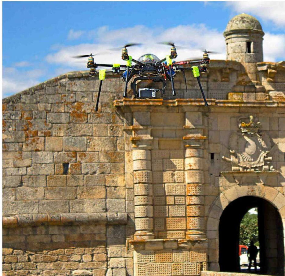
Un dron del grupo de investigación TIDOP analiza los posibles deterioros de un edificio en Almeida (Portugal). EL MUNDO
