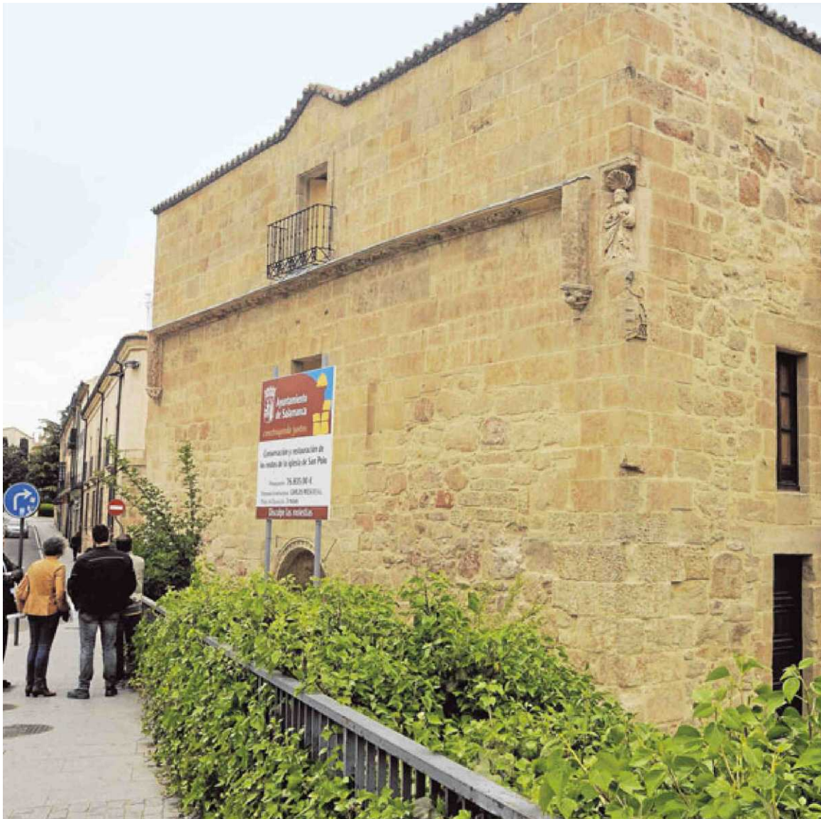
El Ayuntamiento finalizó recientemente las obras en la iglesia de San Polo.
