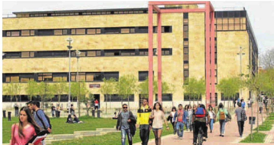
Vista exterior de la Facultad de Derecho, ubicada en el Campus Miguel de Unamuno. :: ALMEIDA
