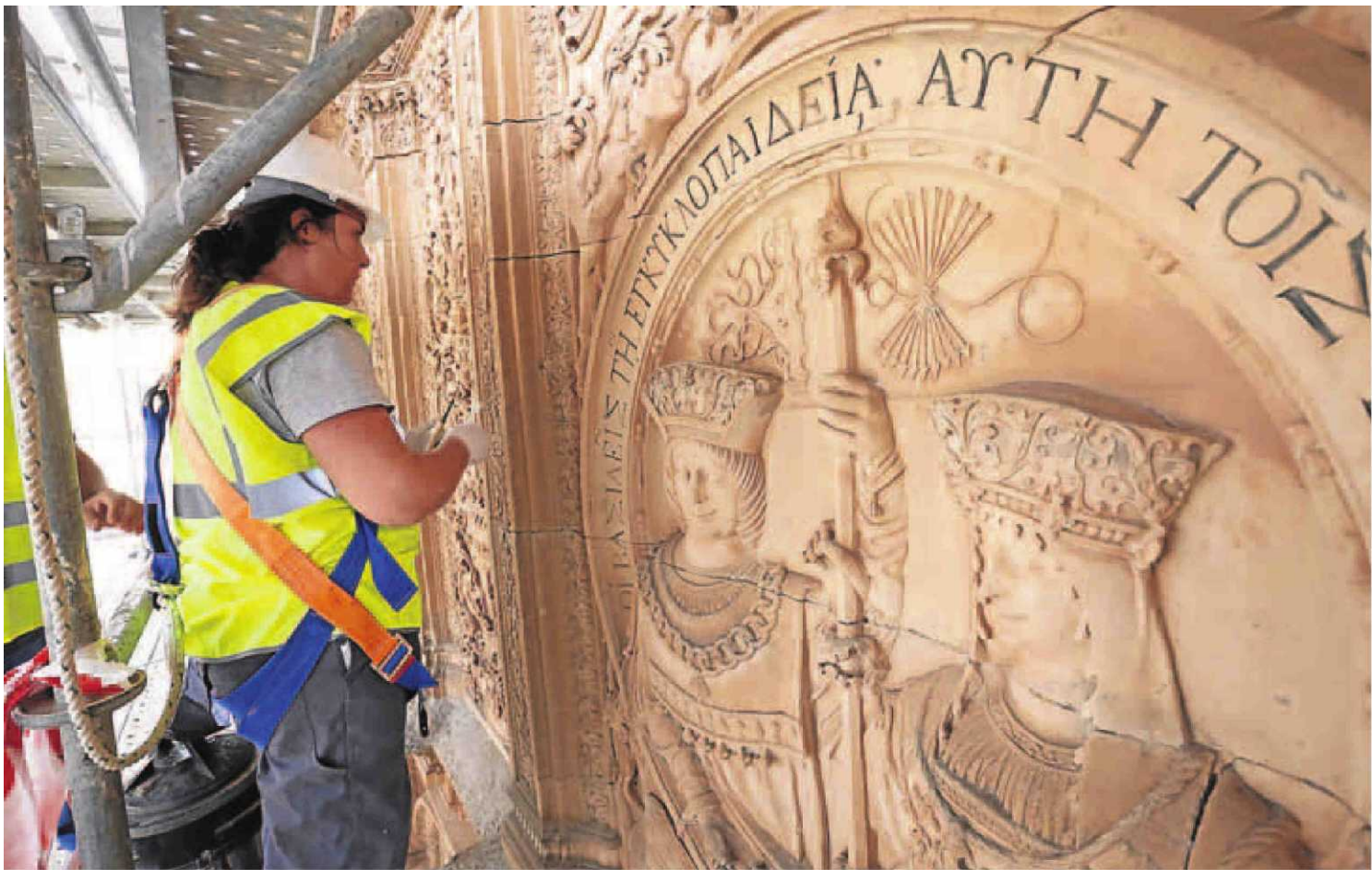
Una de las técnicas que acomete la rehabilitación de la fachada de la Universidad trabaja junto al medallón de los Reyes Católicos. :: MANUEL LAYA
