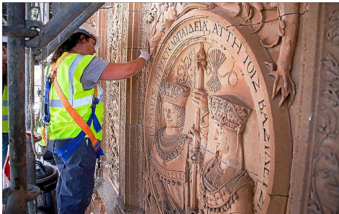
Los técnicos trabajan en la restauración de la fachada de la Universidad de Salamanca. ICAL
