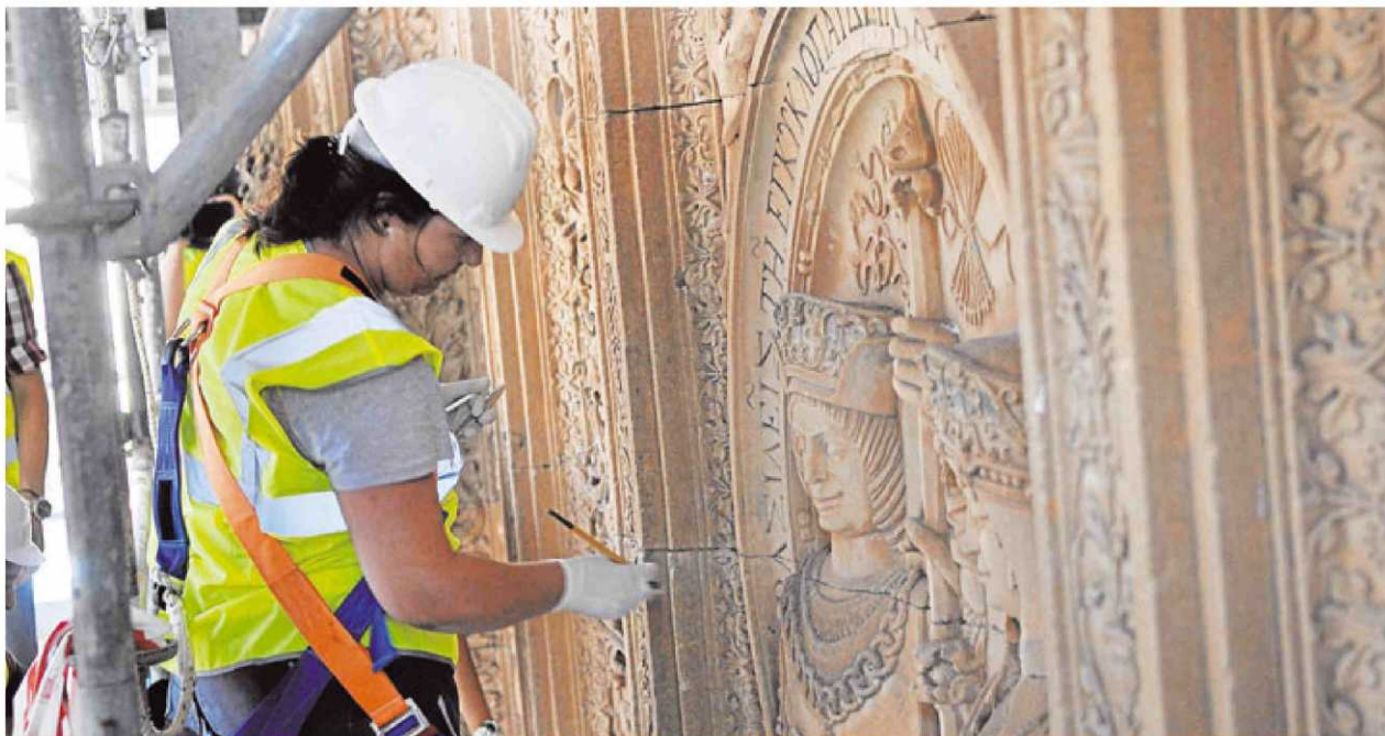
Ya han comenzado los trabajos para la limpieza de la fachada plateresca de la Universidad de Salamanca. | FOTOS: GALONGAR
