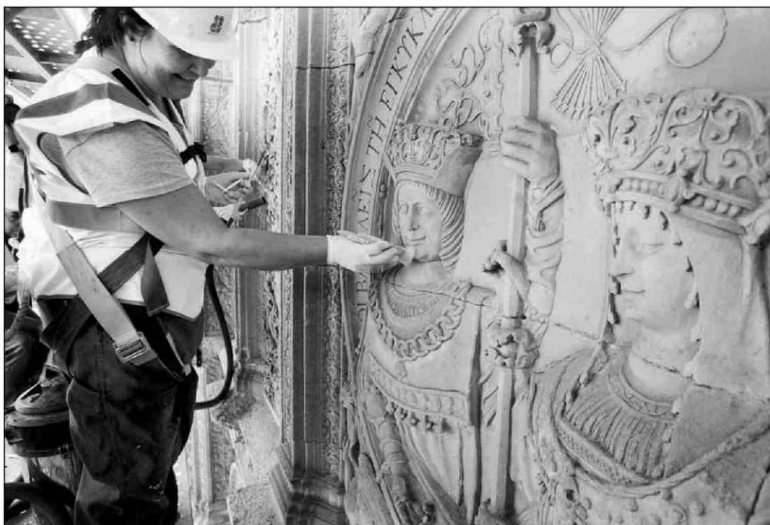
Una operaria participa en la restauración de la fachada de la Universidad de Salamanca. J. M. GARCÍA
