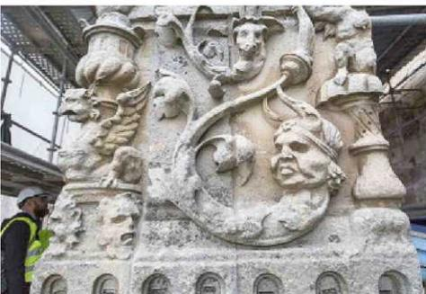
**El reflejo de la lluvia.** El viento y la lluvia, que generalmente suelen ser más fuertes de suroeste en Salamanca, se ejemplifican en uno de los laterales de la fachada, que muestra mayor erosión.
