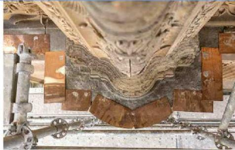
**Protección contra las filtraciones.** Uno de los principales problemas al que se enfrentaban los restauradores era evitar que el agua siguiera deteriorando la fachada y ennegreciera los elementos. Se han protegido zonas con cobre que luego se han tapado y reforzado para que el agua de la escorrentía circule por ellas. Además, en los tres frisos principales se han instalado escapes de agua para conseguir paliar la erosión por humedad.
