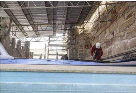
**Una cubierta nueva.** Se ha instalado una nueva cubierta con salida de aire que permita que en los meses de julio y agosto la bóveda que protege no alcance temperaturas muy altas. FOTOS: SOLETE CASADO
